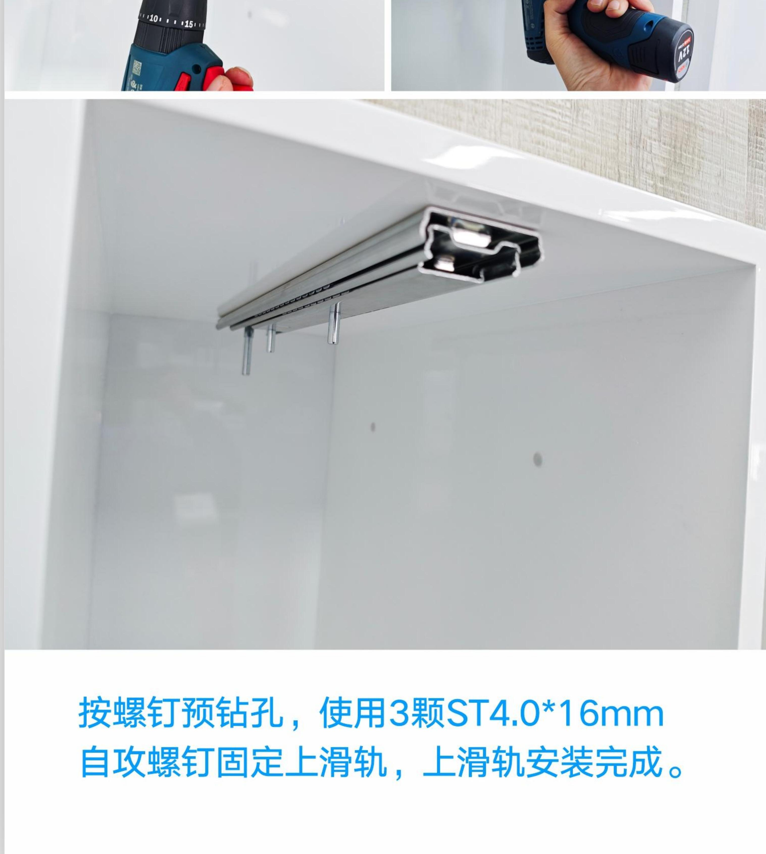
按螺钉预钻孔，使用3颗ST4.0\*16mm
