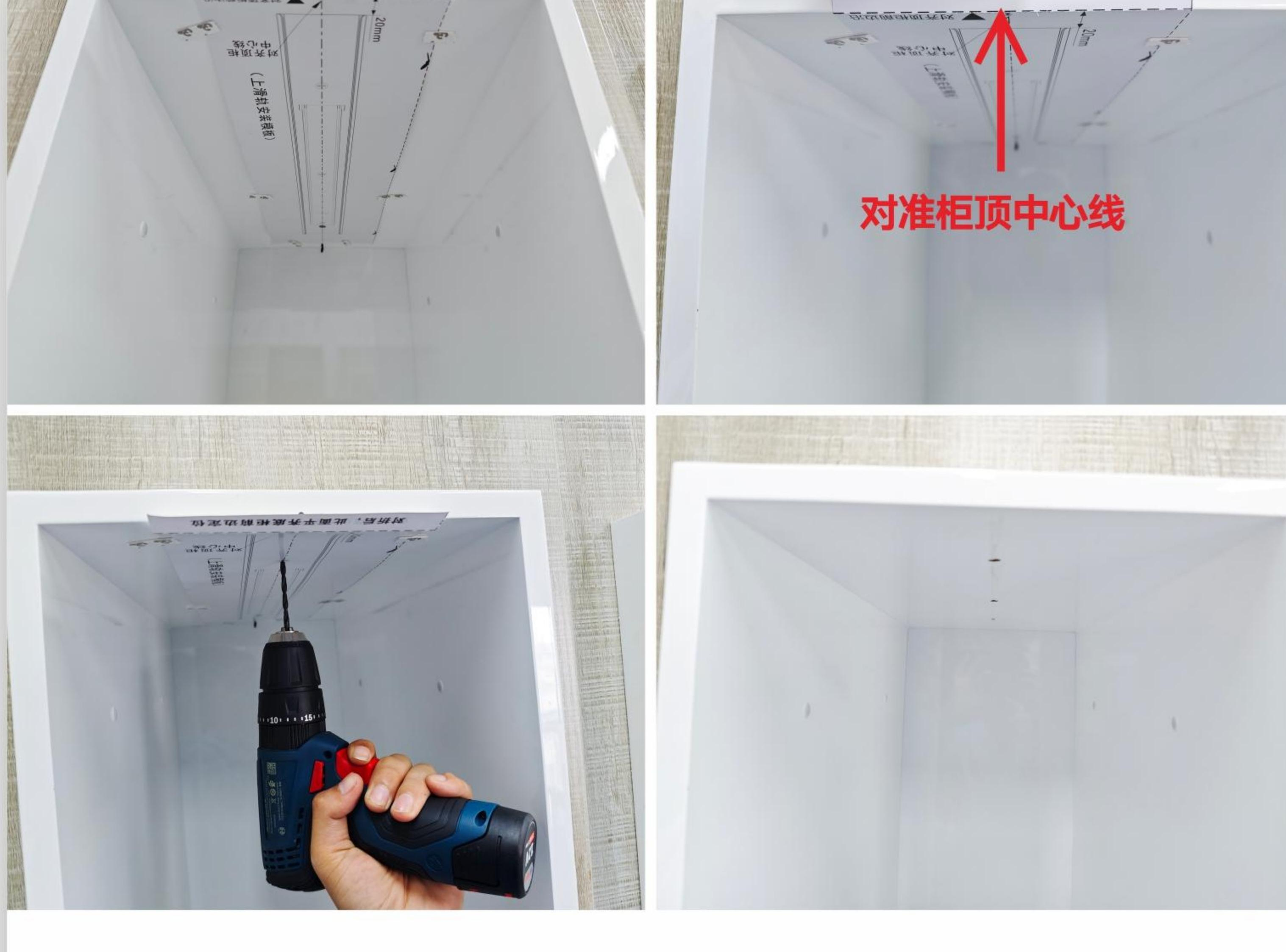
柜顶安装模版中心线对准柜顶中心线，
