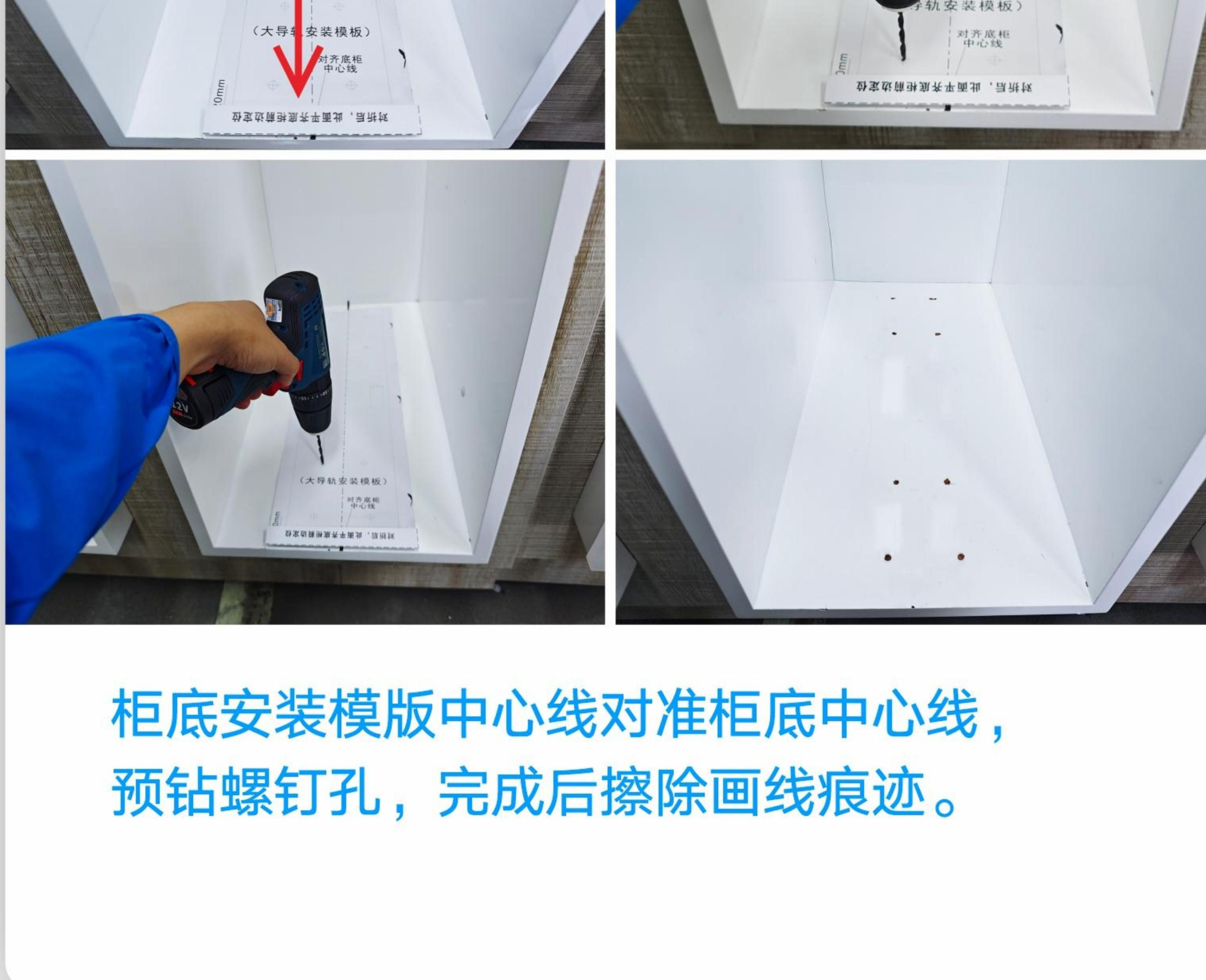
柜底安装模板中心线对准柜底中心线，预钻螺钉孔，完成后擦除画线痕迹。
