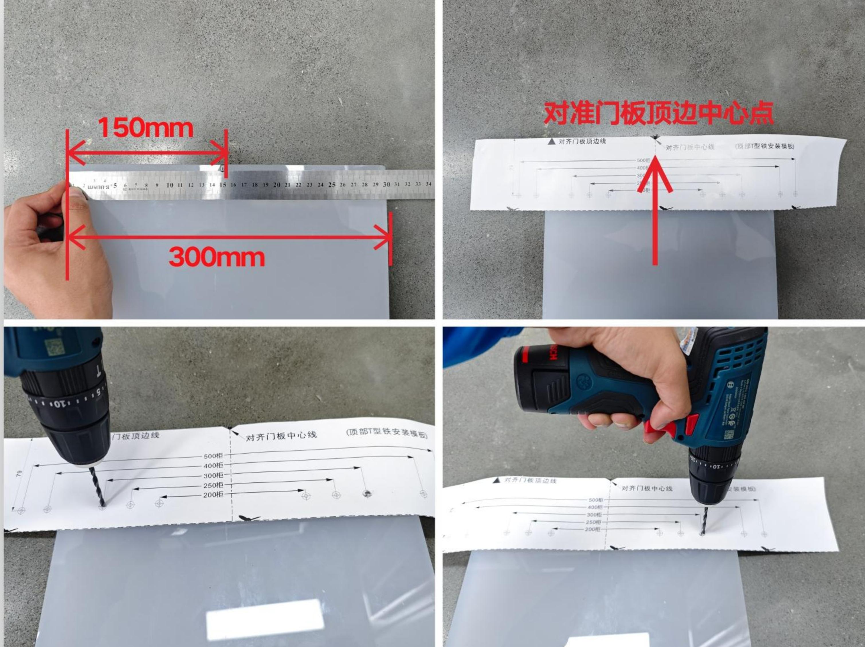
量取柜门顶边中心点，使用顶部T型铁安装模版对准中心点，预钻孔。
